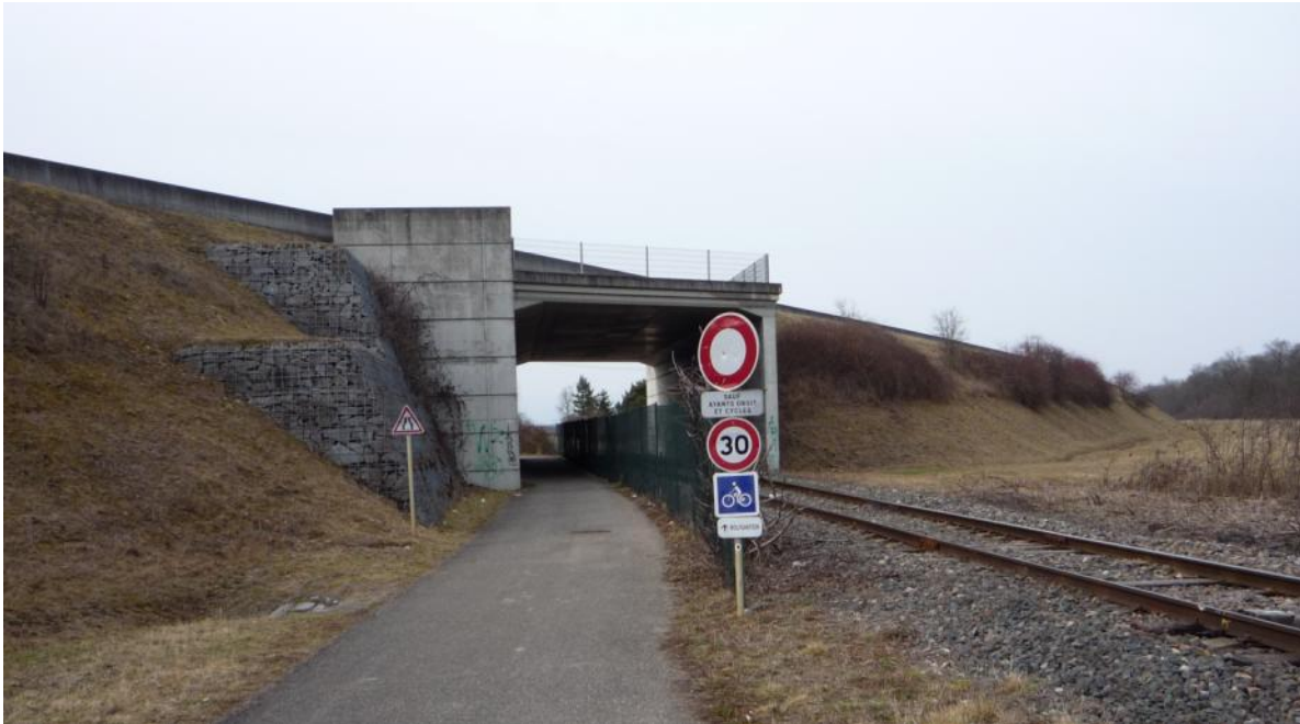
Unterfahrung der RN 415 - km 16
