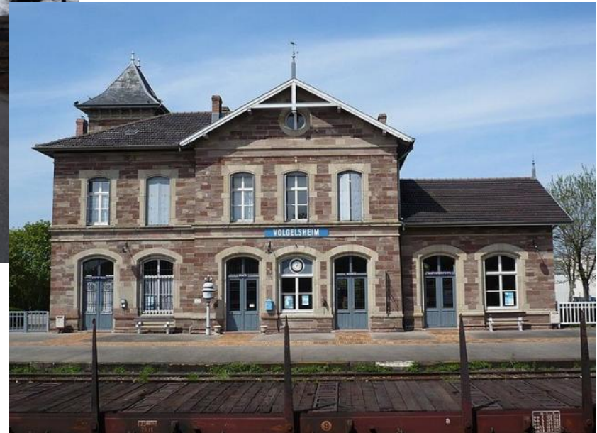
Bahnhof Volgelsheim – km 18
