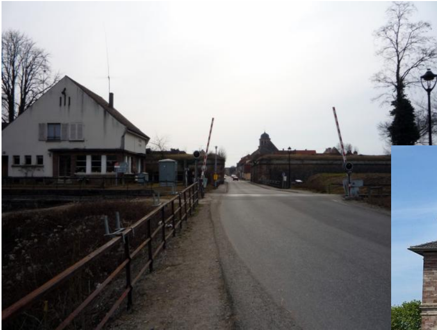
Bahnhof Neuf-Brisach – km 17
