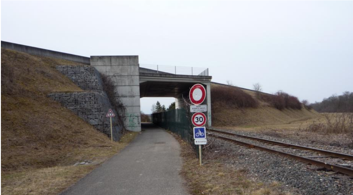
Unterfahrung der RN 415 - km 16
